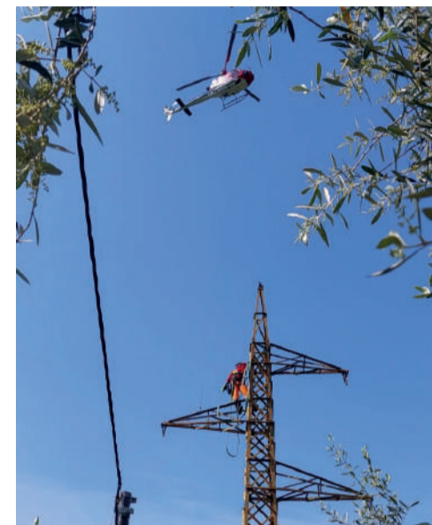
Recupero elettrodotto aereo
